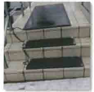
<ヒートマットの設置例>
