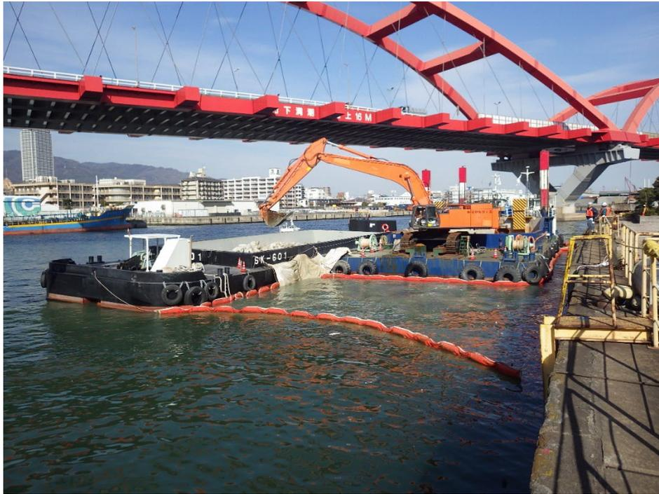
図 10 北護岸捨石施工
